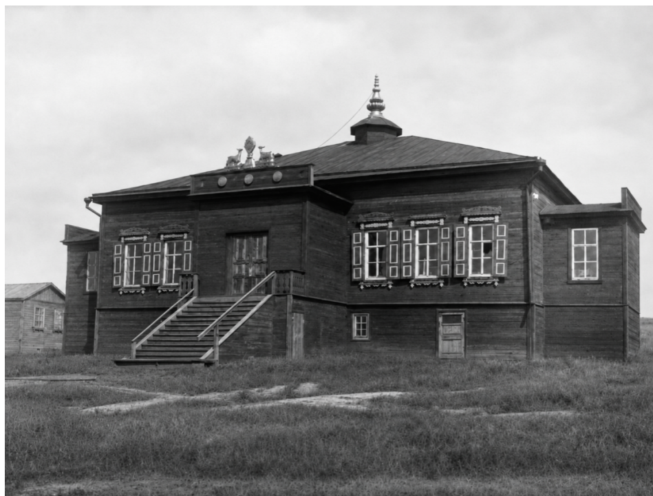
Рис. 1. Здание «Цанит-Чоре» (НМ РК. КП — 946)
